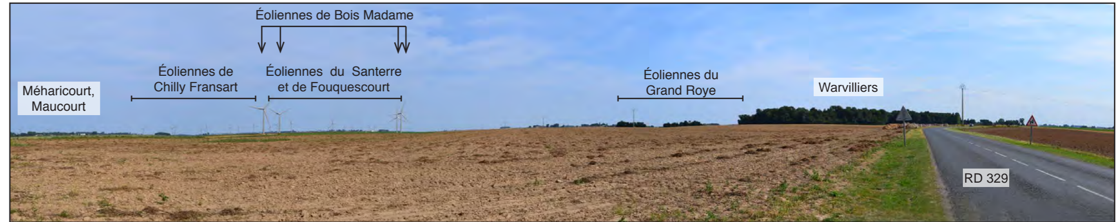
État initial - Vue panoramique
