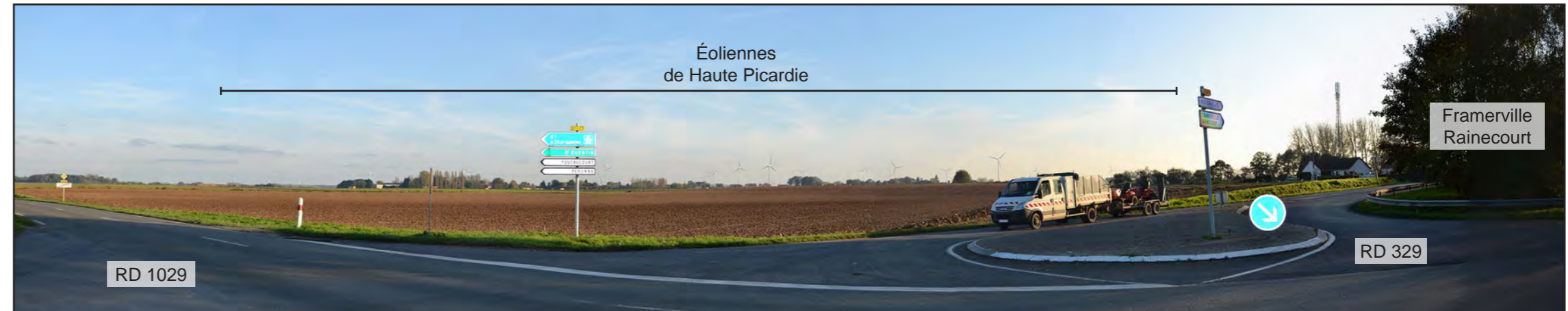
État initial - Vue panoramique
