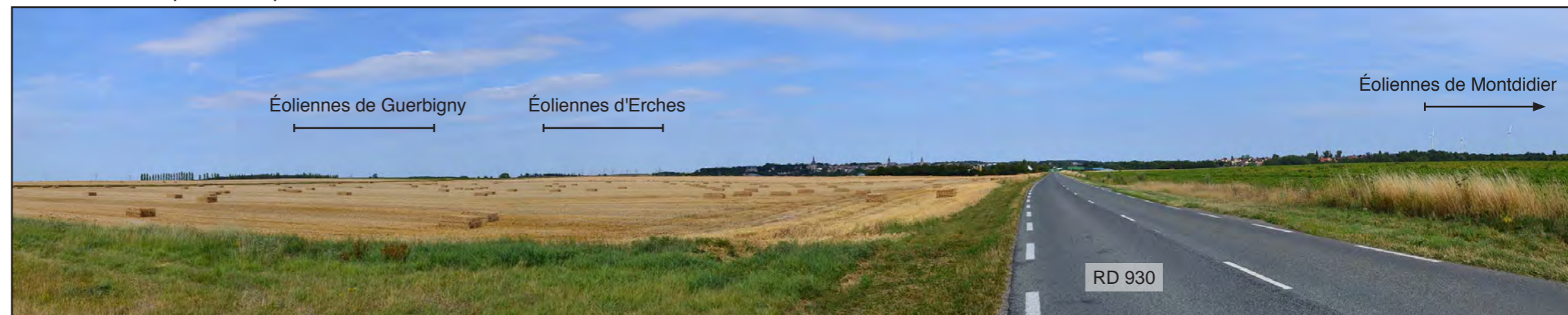
État initial - Vue panoramique
