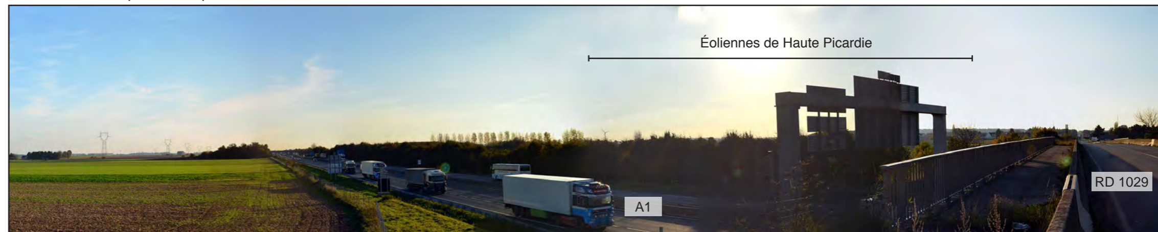
État initial - Vue panoramique
