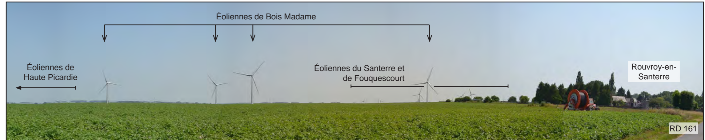
État initial - Vue panoramique
