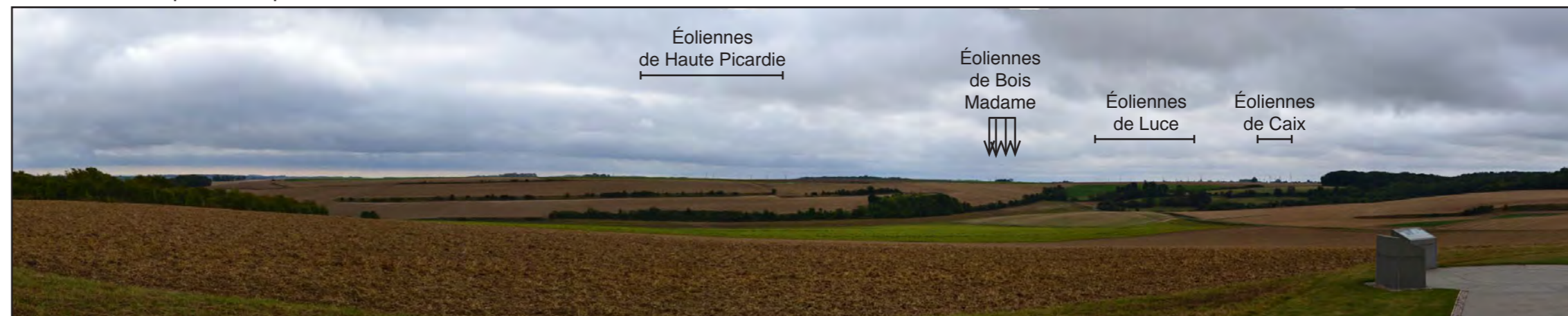
État initial - Vue panoramique
